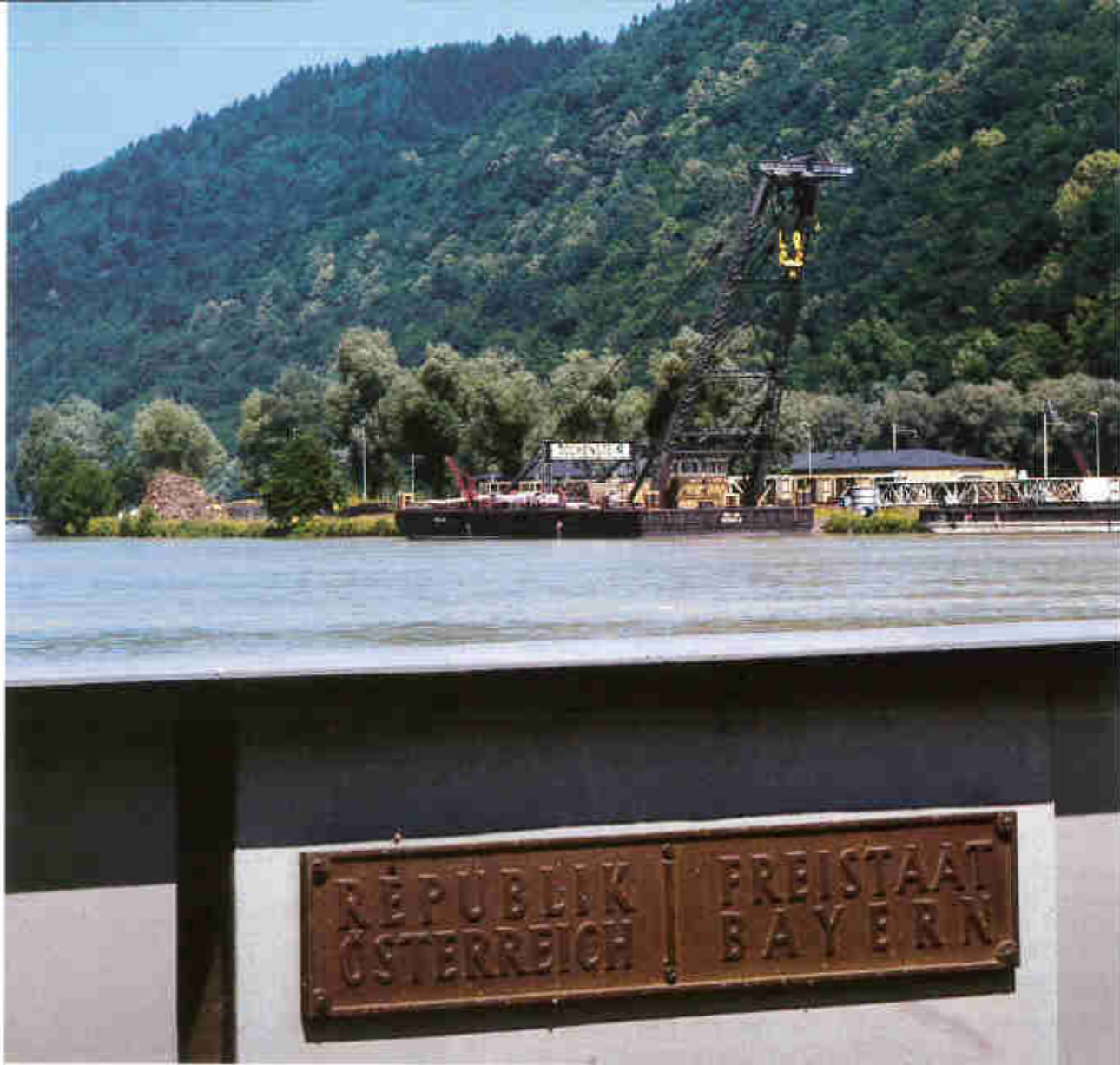
Kraftwerk Jochenstein: Oberösterreichisch-bayerische Grenzmarke (Republik Österreich und der Bundesrepublik Deutschland) im Bereich der Wehranlage
