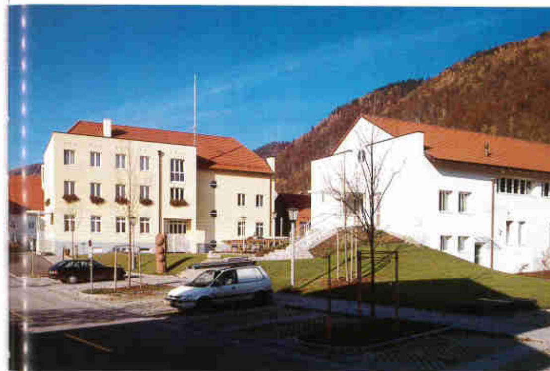
Von 1993-1994 entstand aus dem ehemaligen Gemeindeamt ein modernes Gemeindezentrum
