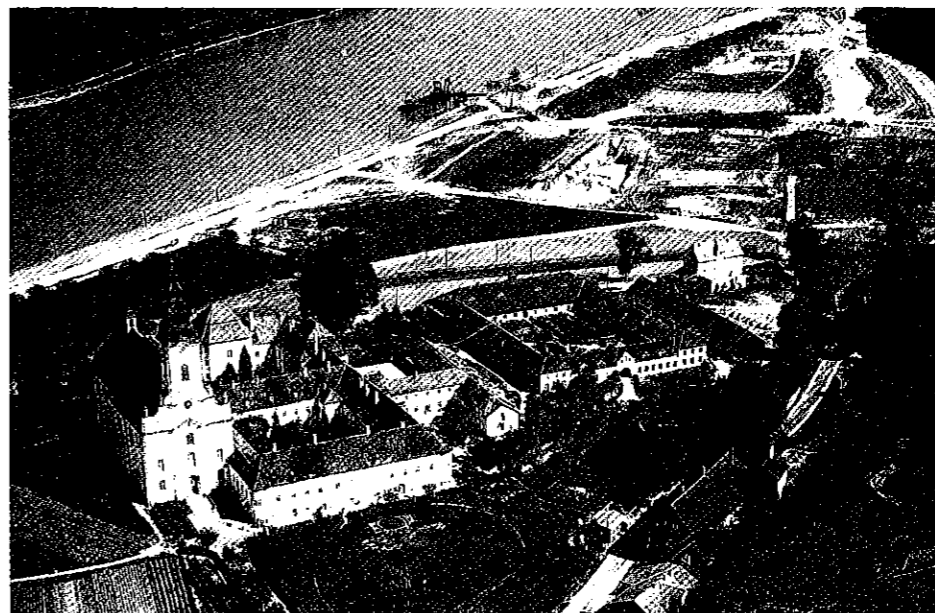
1952-1956 Bau des Kraftwerkes Jochenstein. Mit dem Schottermaterial der Unterwassereintiefung wird das Klosterfeld samt Bundesstraße auf das heutige Niveau aufgeschüttet.
