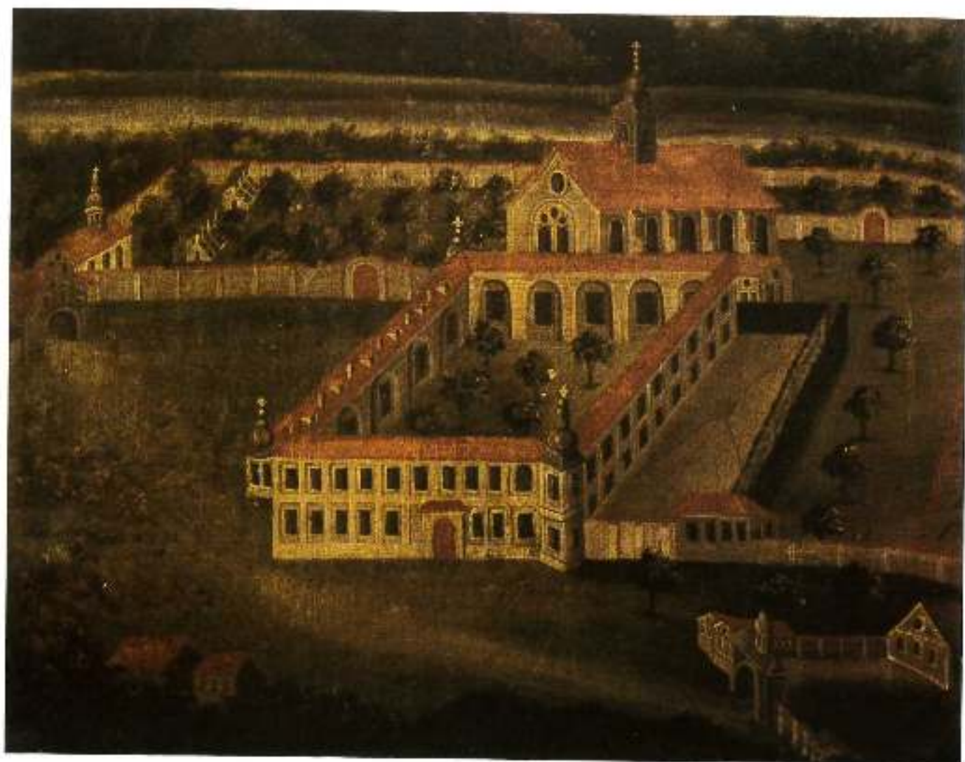
Ansicht des Klosters von Süden vor dem Brand 1699. Die gotische Kirche ohne Querschiff, fünf Joche lang, mit Strebpfeiler und Dachreiter, aber ohne Turm. Stiftsarchiv Engelhartzell
