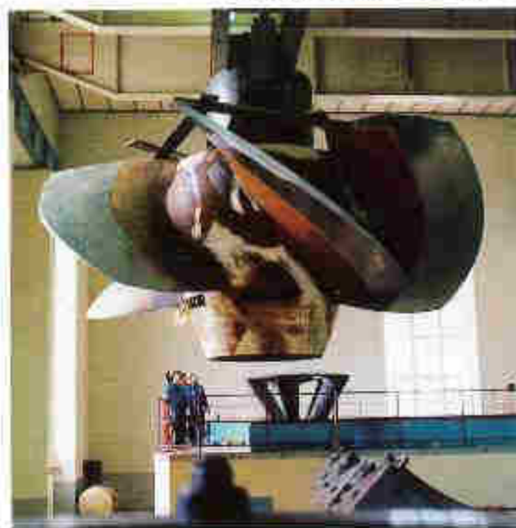
Nach vierjähriger Einsatz wurden 1994 die Laufradschaufeln ersetzt
