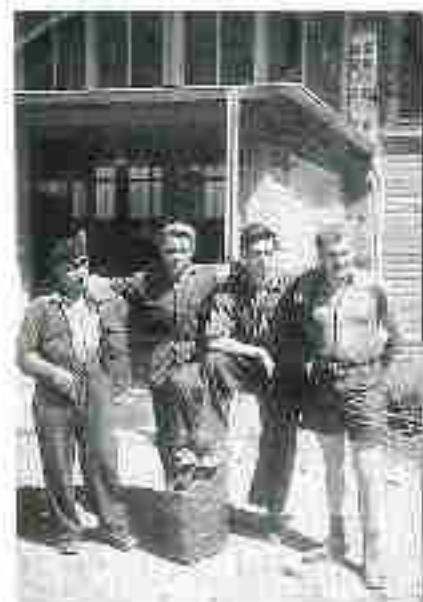
Eduard Leidinger aus Stadt mit Arbeitskollegen auf der Kraftwerksbaustelle
