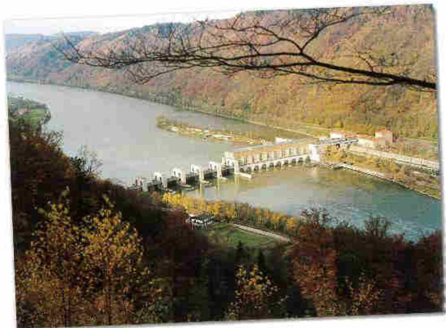
Das Donaukraftwerk Jochenstein 1994
