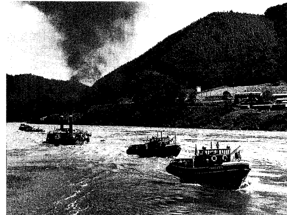
Den bergwärtsfahrenden Schiffen mußte in der durch die Baustelle verengten Fahrrinne mit den Eisbrechern »Krämpelstein« und »Vichtenstein« Schlepphilfe gegeben werden
