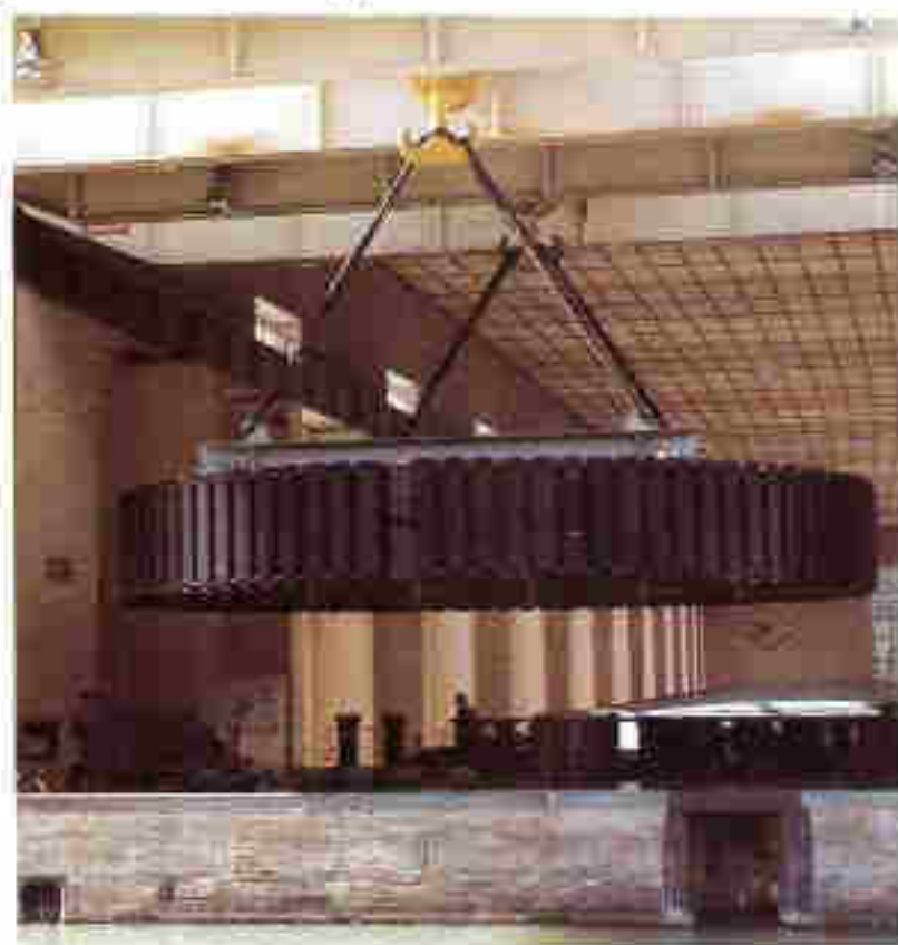
Ausbau des Generatorrotors bei der Turbinen-großrevision 1994
