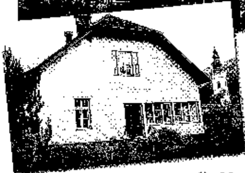
Die »Madlsperger Villa« oder das »Notarhaus« – durch eine geschickte Renovierung wieder ein Schmuckhästchen im Marktbild. Das kleine Bild zeigt den Zustand 1962
