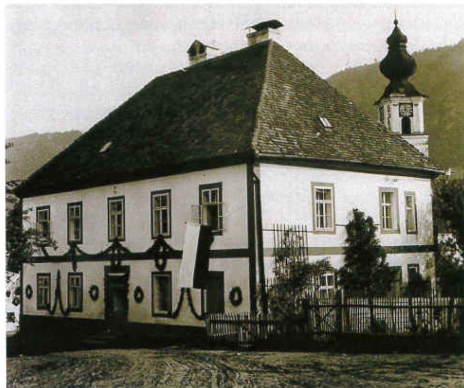
Bis zu ihrem Abriß 1992 blieb die 1828 erbaute Volksschule Engelhartzell in ihrem äußeren Bild unverändert – unser Bild zeigt das Schulgebäude 1928 anlässlich der 100-Jahr- feier der Volksschule
